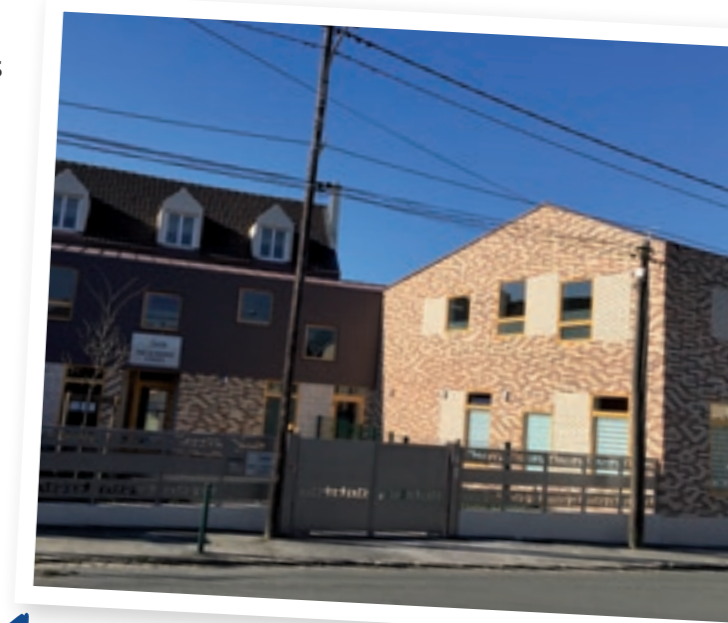
La nouvelle extension sur la rue pour un accueil du SESSAD intégralement déployé
